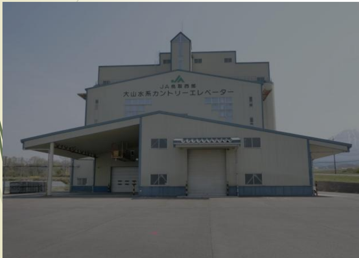
大山水系カントリーエレベーター
