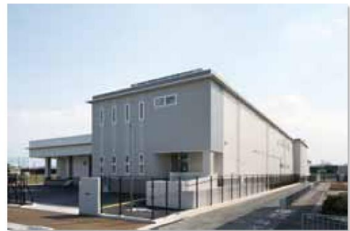
給食センター外観
