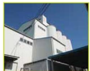
(亀岡カントリーエレベーター)
