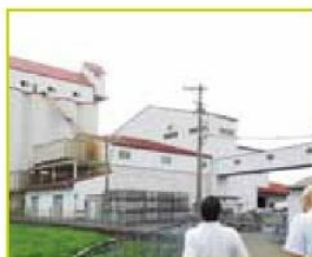
(守山カントリーエレベーター)
