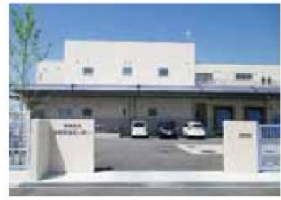
河南町立学校給食センター
