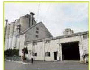
坂出カントリーエレベーター
