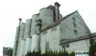
坂出カントリーエレベーター
