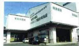
亀岡カントリーエレベーター
