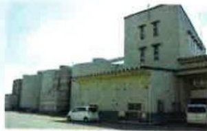
岩木カントリーエレベーター
