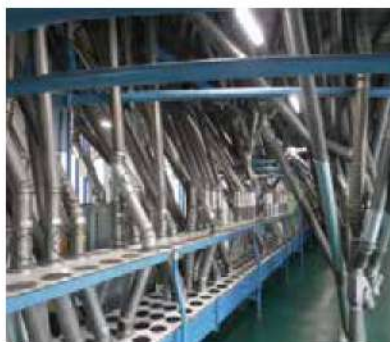
製粉工場の内部の様子
