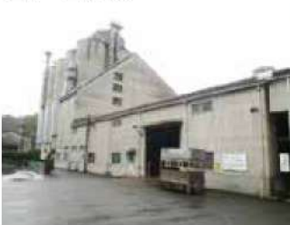
坂出カントリーエレベーター
