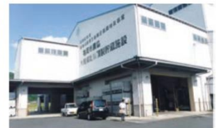
亀岡カントリーエレベーター
